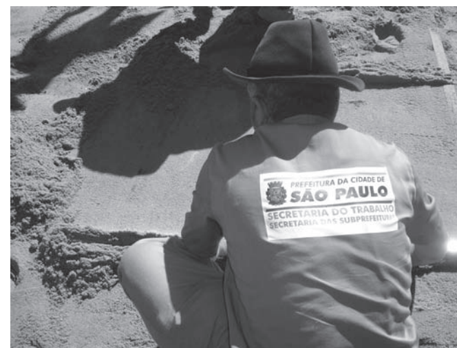
Execução da obra da calçada da Rua Cardeal Arcoverde.
