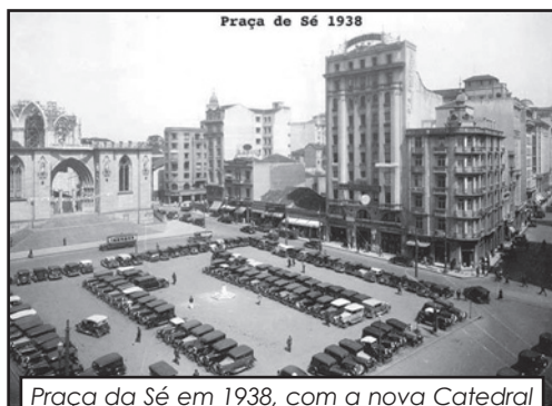
Praça da Sé em 1938, com a nova Catedral em construção, tomada pelos automóveis. Apesar de serem poucos, já começavam seu avanço voraz sobre os espaços públicos. Reprodução: autor não identificado.
